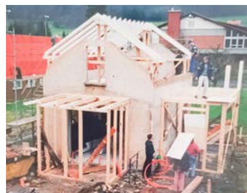
In der Umbauphase
